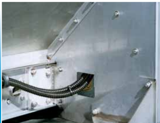
Estructura con plancha inox
